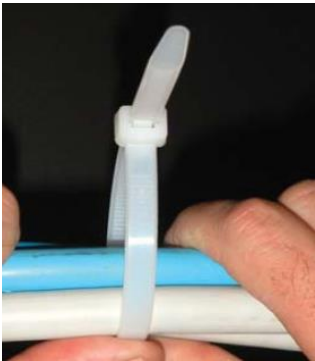
1. De band van de kabelbinder door de kop halen.
